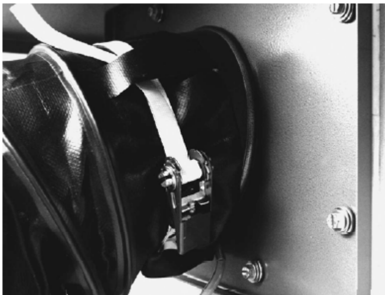
Abbildung: Kaltluftschlauch mit goldsaat Spannratsche am Ausblasrohr
