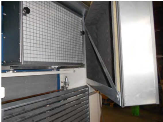
Abbildung: Filtermattenwechsel
