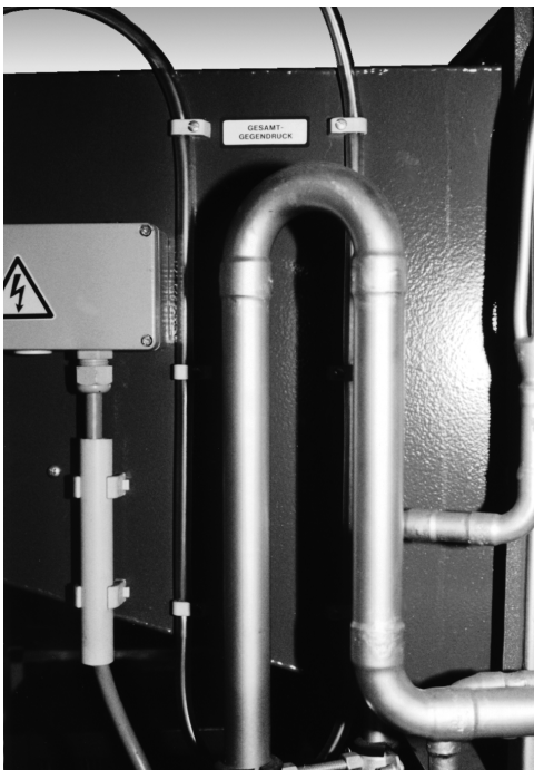
Abbildung 5-10: U-Rohr Gegendruckkontrolle
