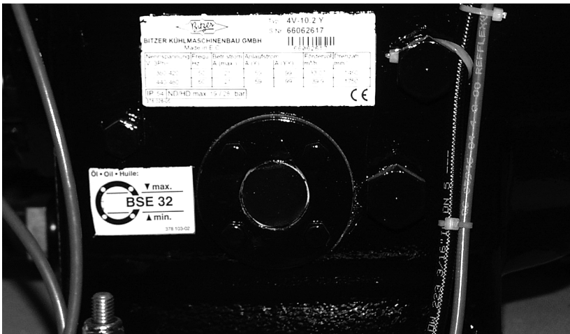
Abbildung 5-12: Schauglas für Ölstand im Kompressor
