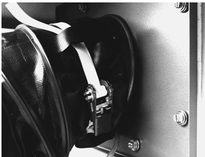
Abbildung 4-5: Kaltluftschlauch mit goldsaat Spannratsche am Ausblasrohr
