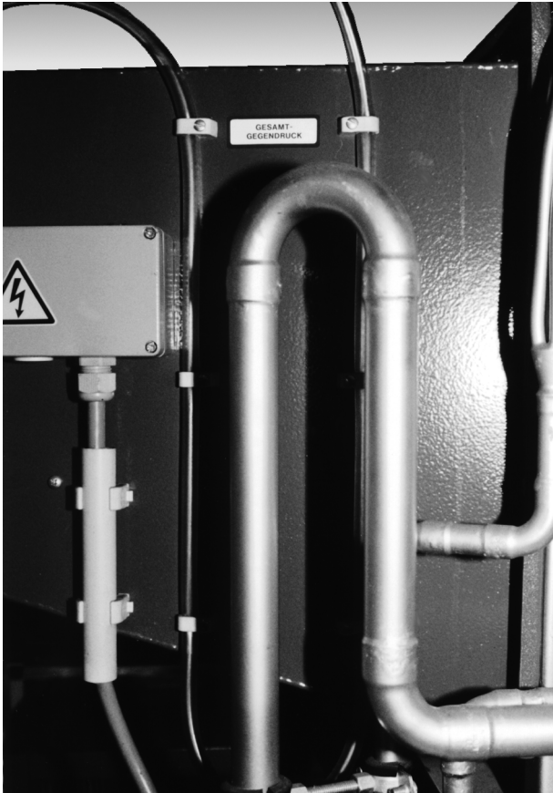
Abbildung 5-2: U-Rohr Gegendruckkontrolle
