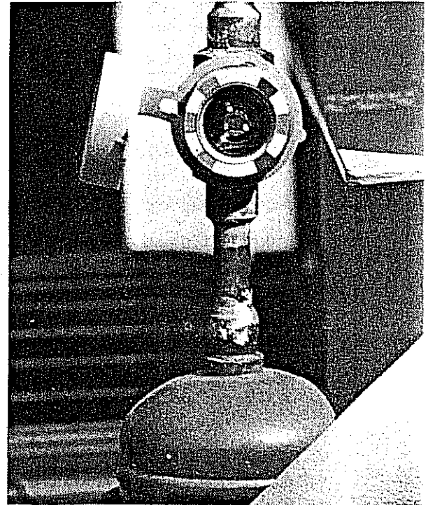
Bild 21: Kältemittelschauglas mit Indikator
