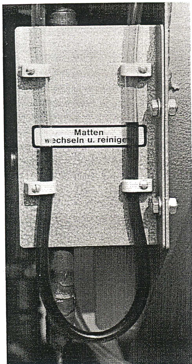
Bild 18: U-Rohr-Manometer (27) zur Prüfung des Verschmutzungsgrades der Filtermatte
