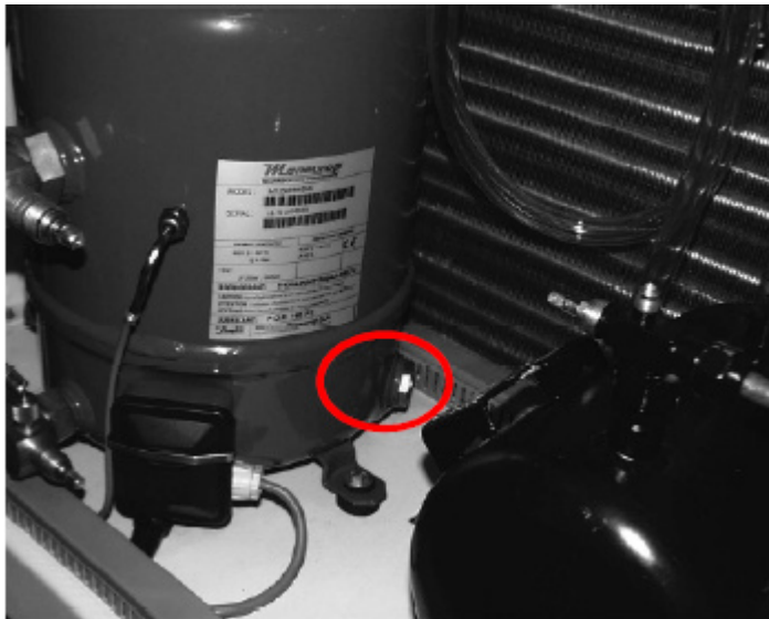
Abbildung: Schauglas für Ölstand im Kompressor
