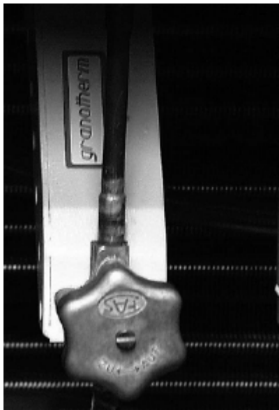
Abbildung : granotherm-Ventile
